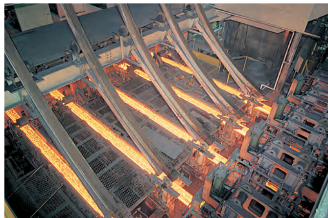
●5ストランド連続铸造設備(筑波工場)
