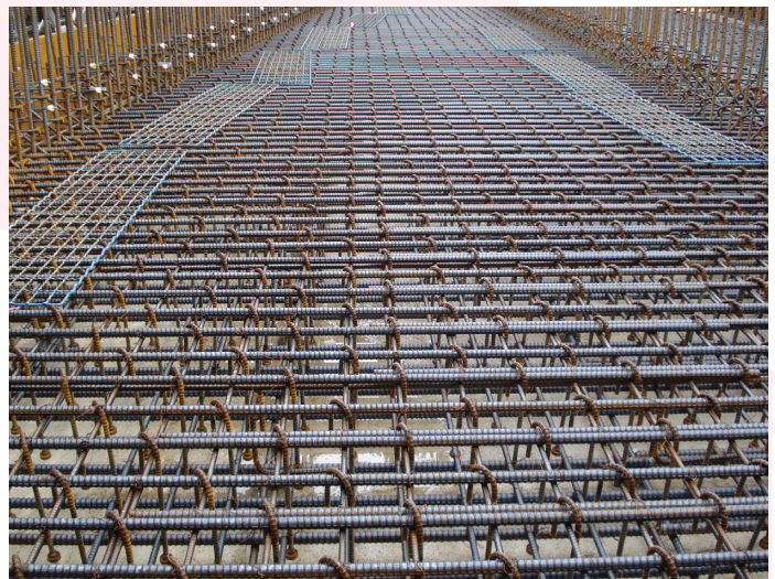
フリッパーの配筋状況
